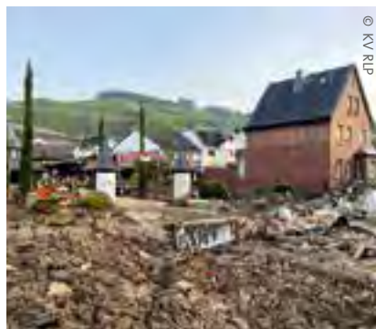
Die Flut im Juli richtete – wie hier in Dernau – eine riesige Zerstörung an.
